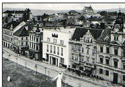
Opakovaně byla pro účely Muzea umění a designu navrhována také bývalá benešovská Městská spořitelna vystavěná podle projektu místního rodáka architekta Otakara Novotného.
