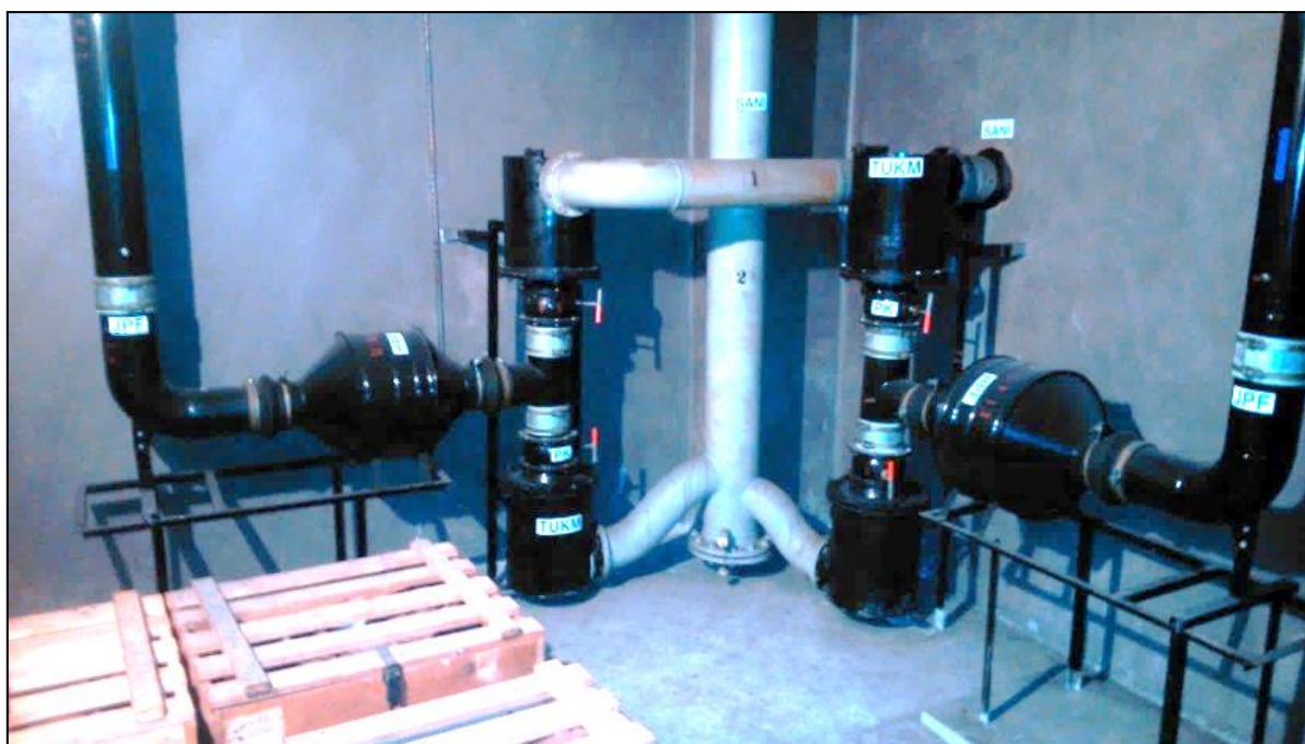
Působivé prvky filtrační technologie protiatomového krytu. Sousední mazutová kotelna inspirovala k vytvoření projektu kombinované stálé expozice designu 50. – 80. let 20. století.
